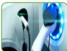
Instalación de punto de recarga de vehículos eléctricos
